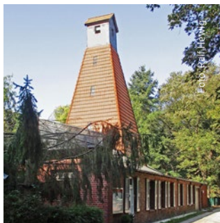
Bohrturm des Krefelder Sprudels 14
